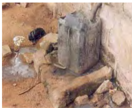
Photo 1 : Evacuation des eaux de douche non conforme aux règles d'hygiène.
