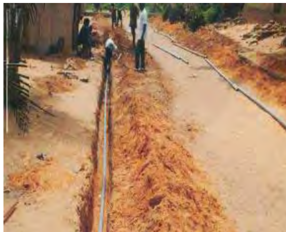
Photo 3 : Pose d'un collecteur secondaire
