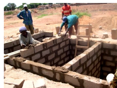
Réalisation de latrines VIP collectives de démonstration
