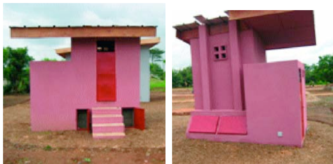
Latrine associée à une douche à Tiémélékro (Côte d'Ivoire) construite par CREPA CI et Architectes Sans Frontières
