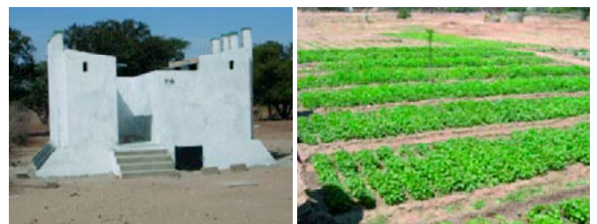
Latrine scolaire (Vue de face) et Périmètres Ecosan à Keur daouda Cissé (Sénégal)
